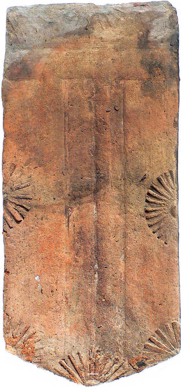
Der handgemachte Spitzschnitt stammt aus dem 19. oder frühen 20. Jahrhundert. Die mit der Kante einer Schindel in den frischen Ziegel eingedrückten Viertel- oder Halbsonnen waren ein beliebtes Motiv.
