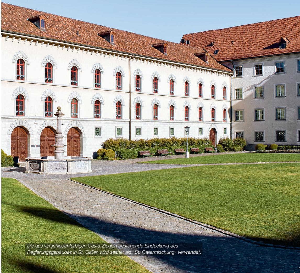
*Die aus verschiedenfarbigen Casta-Ziegeln bestehende Eindeckung des Regierungsgebäudes in St. Gallen wird seither als «St. Gallermischung» verwendet.*
