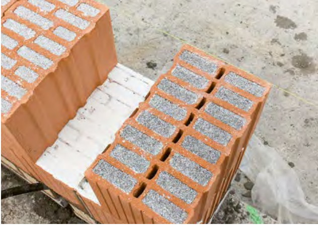
1. An Fenster- und Türleibungen Halbsteine setzen
