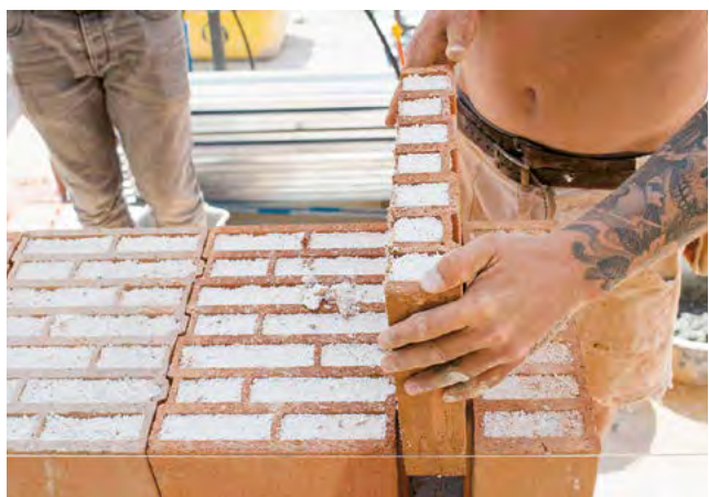
12. Passtücke einfügen
