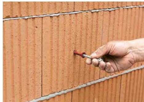
2. Dübel (ggf. mit Schraube) ansetzen
