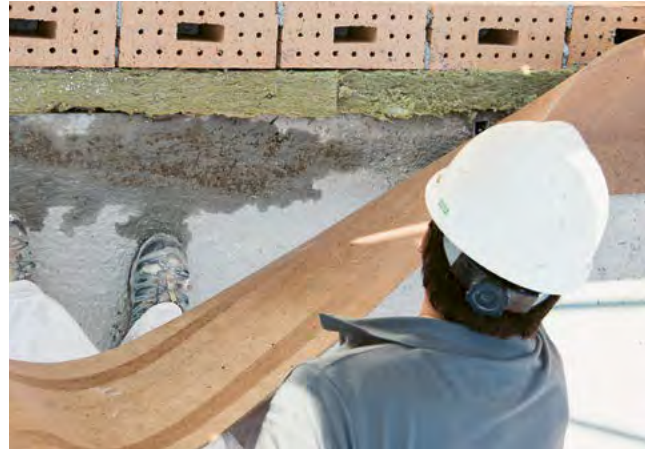
2. Für neue Geschosswand Trennlage ausrollen z.B. Porotherm-Pronouvo-Wandlager
