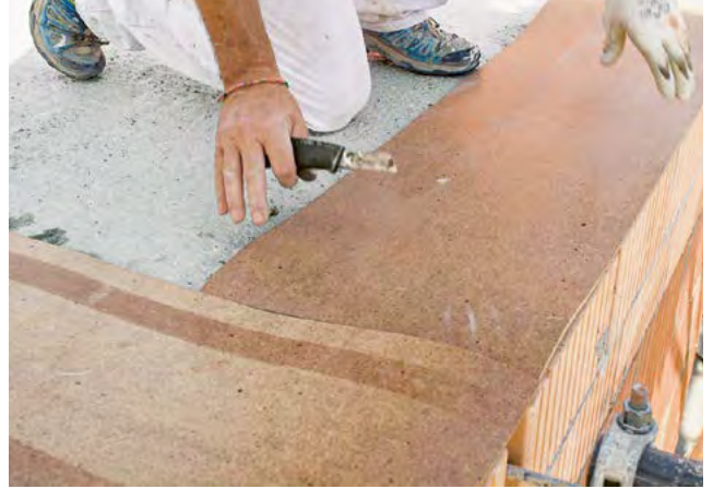
2. Trennschicht bzw. Lager ausrollen
