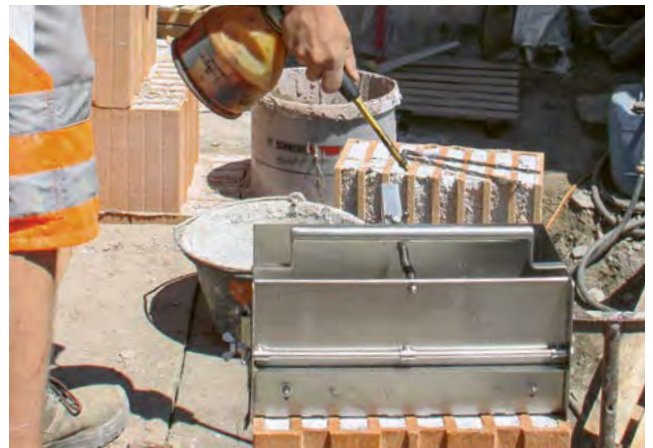
4. Mörtelschlitten mit Schalöl vorbereiten
