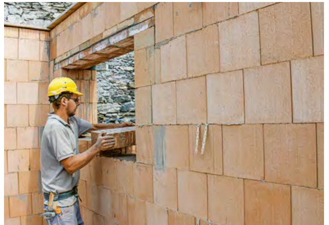
4. Brüstung zwischen den Leibungen ab letzter Normalschicht ausgleichen
