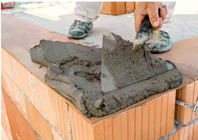
3. Ansetzmörtel zum Ausgleich auftragen
