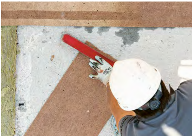
3. Porotherm-Pronouvo-Wandlager zuschneiden
