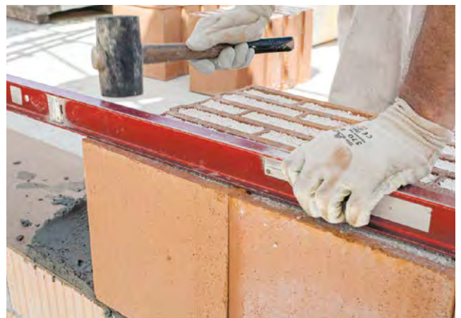
6. Erste Schicht «nass in nass» oder nach Aushärtung mit Dünnbettmörtel beginnen
