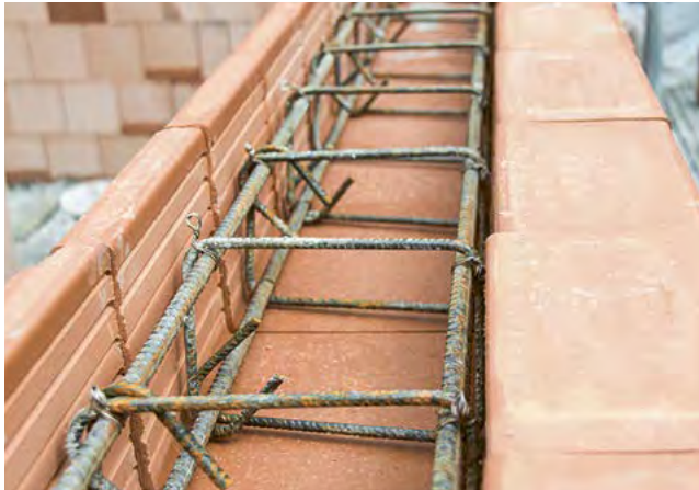
7. Bewehrungskorb in U-/WU-Schale einlegen
