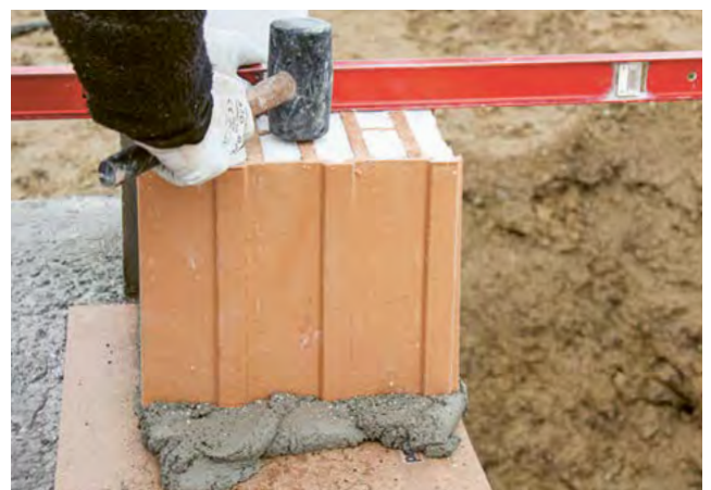
6. Mit Wasserwaage und Gummihammer waagrecht und senkrecht ausrichten
