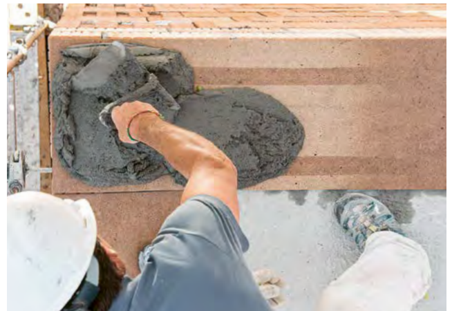
4. Ansetzschicht aufbringen
