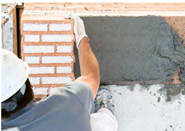
5. Neue Geschosswand hochziehen
