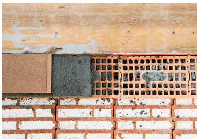
2. Auf dem Mörtelbett liegen die Deformationslager
