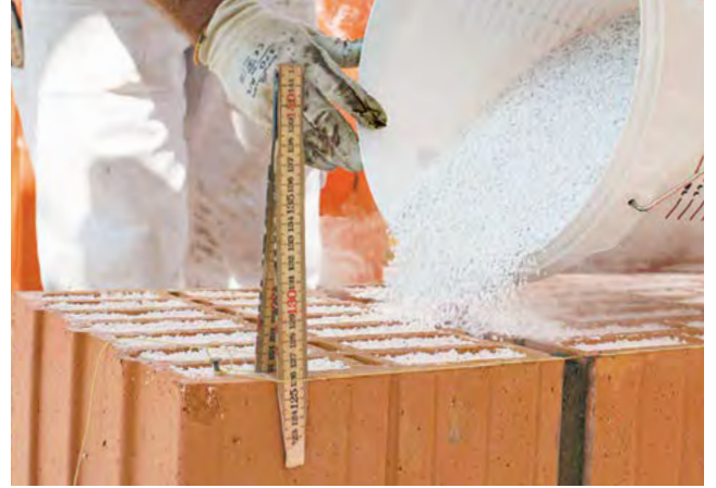
14. Lücke von oben grosszügig mit Perlit auffüllen
