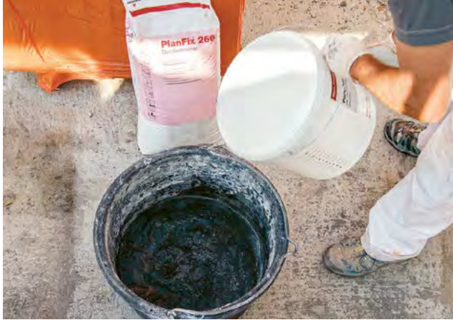
1. Wasser für Mörtelmischung genau abmessen
