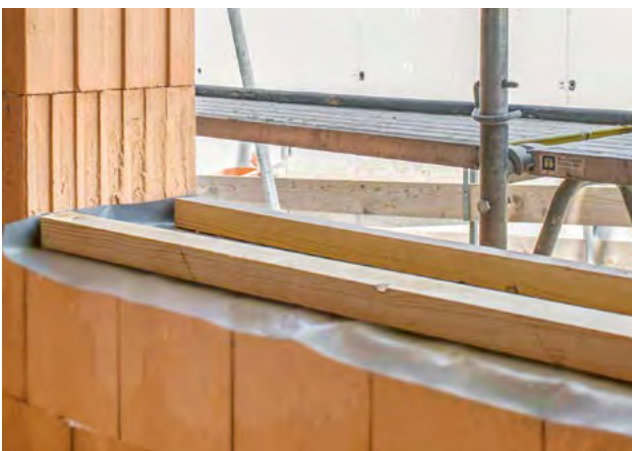
5. Brüstung während der Bauphase vor Witterung schützen
