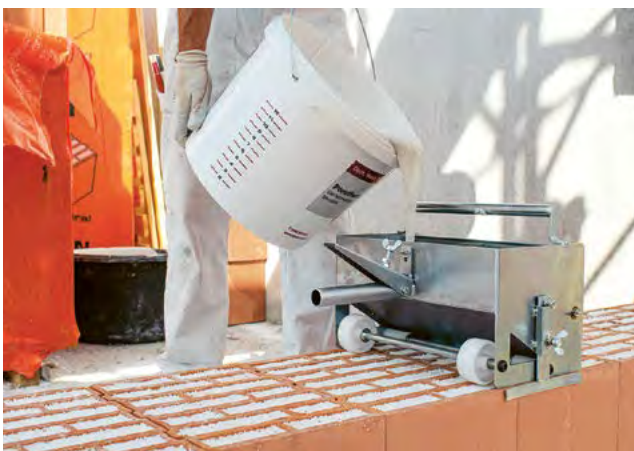
5. Mörtelschlitten füllen
