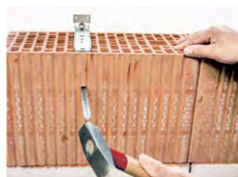
Lochschiene einschlagen
