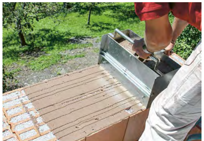
6. Schlitten gleichmässig ziehen und Mörtel auftragen
