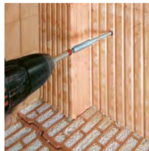
3. Stein im Drehgang bohren
