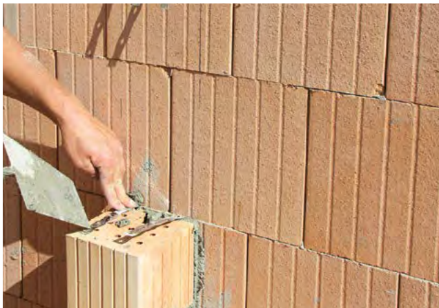
3. Innenwand hochziehen und einbinden
