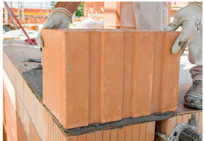
4. Den ersten Stein in der Ecke setzen
