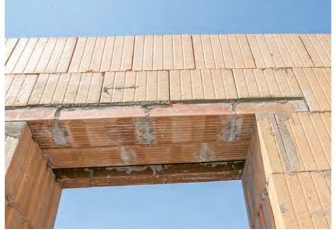
2. Stossfugen bei Sturzübermauerung mit Dünnbettmörtel füllen (tauchen)
