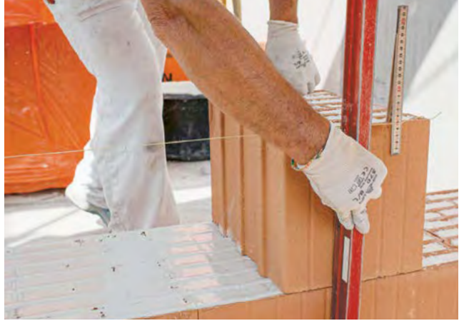
8. Richtschnur ziehen und Ausrichtung prüfen
