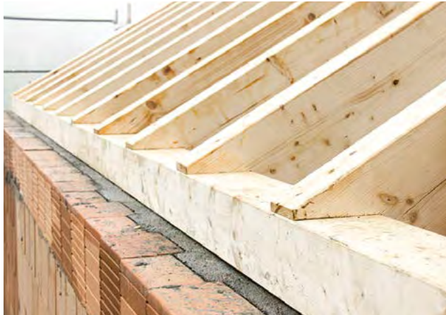
8. Ausbetonieren und z. B. Fusspfette befestigen
