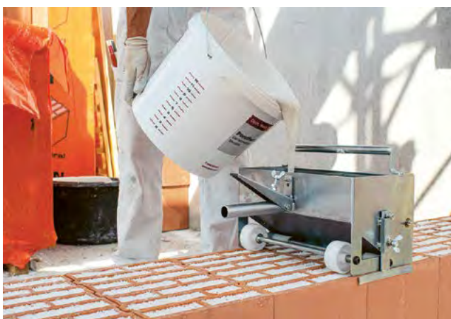
5. Remplir la luge à mortier
