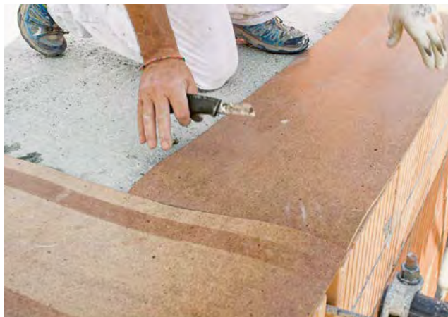
2. Dérouler la couche de séparation ou l'appui
