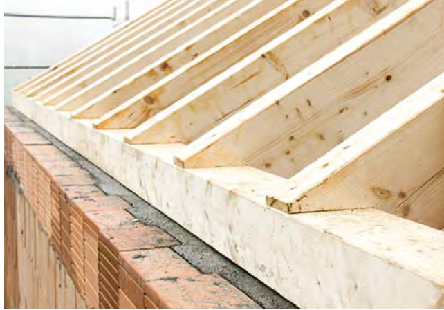
8. Bétonner et, p.ex., fixer la sablière
