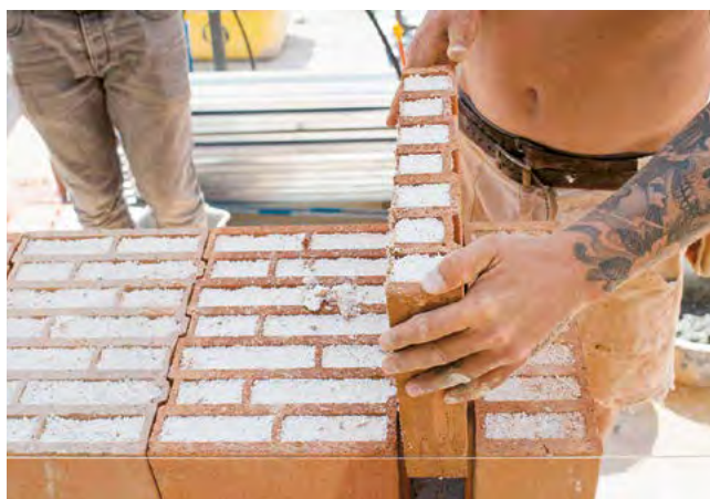
12. Insérer la pièce d'ajustement
