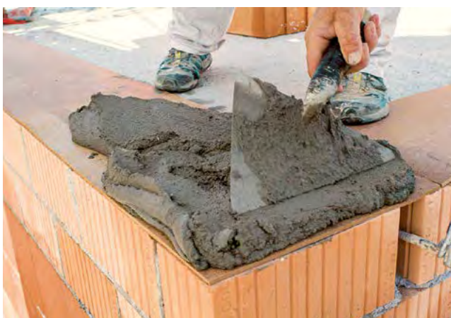
3. Appliquer le mortier de pose pour égalisation
