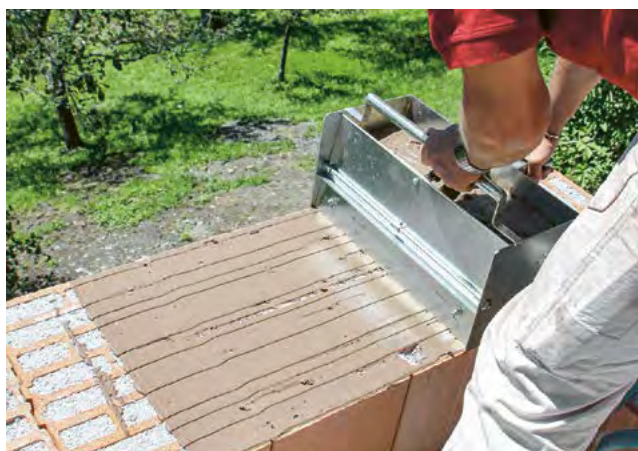
6. Tirer la luge régulièrement et appliquer le mortier
