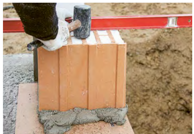
6. Aligner horizontalement et verticalement à l'aide d'un niveau à bulle et d'un marteau en caoutchouc
