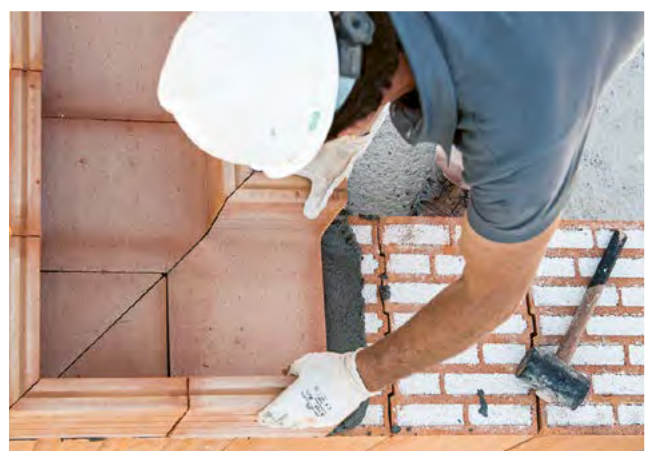
6. Maçonner des coques U-/WU
