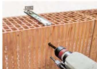
Prépercer un trou à env. 8 cm sous le bord
