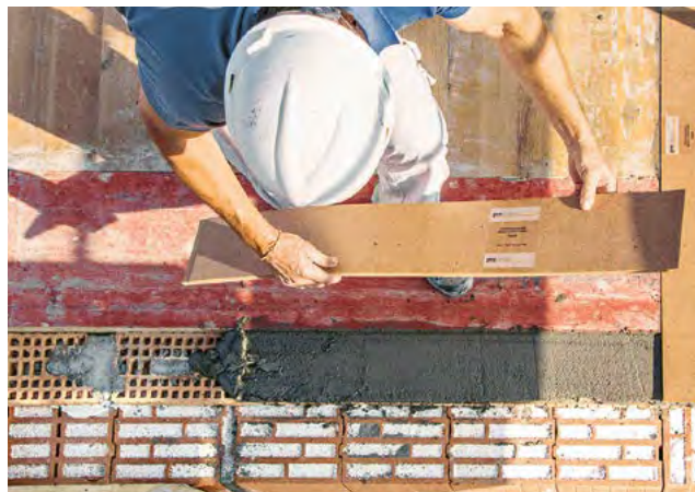
1. L'appui de déformation excentrique, avec bande latérale tendre sur une face et noyau porteur est ajusté
