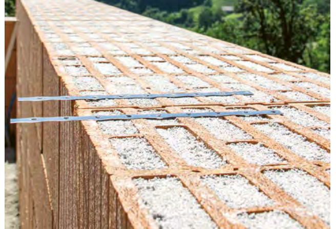
2. Positionner les bandes d'ancrage
