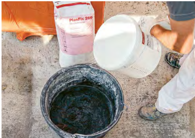
1. Mesurer précisément l'eau pour le mélange du mortier
