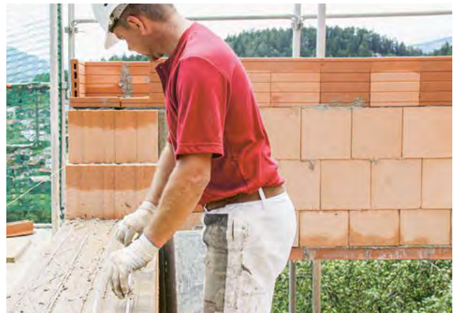
4. Poser l'armature de joint d'assise au mortier en couche mince
