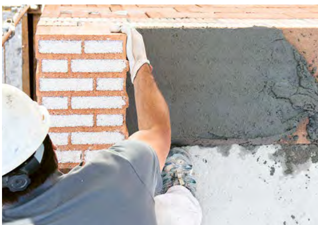
5. Monter le nouveau mur d'étage
