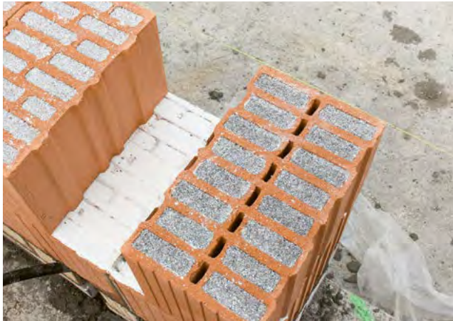
1. Poser des demi-briques au niveau des embrasures de fenêtre et de porte
