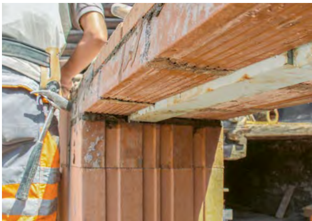
3. Séparer thermiquement les solutions de linteau
