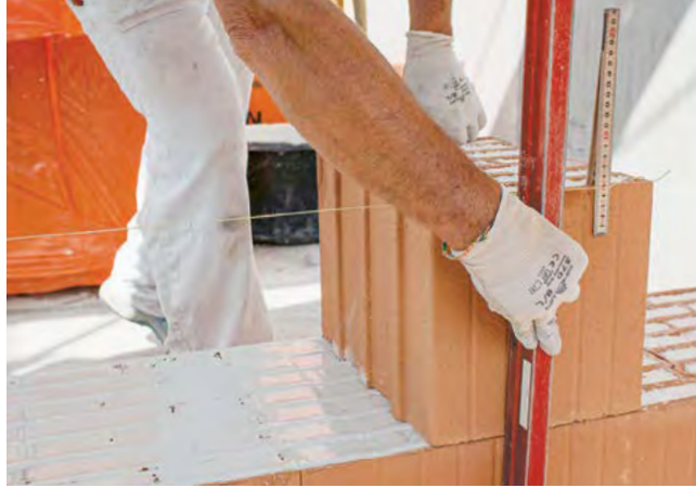
8. Tendre le cordeau et vérifier l'alignement
