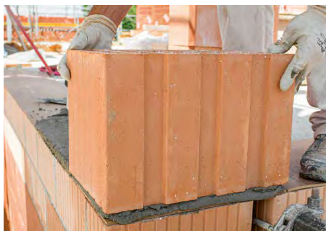
4. Placer la première brique dans l'angle
