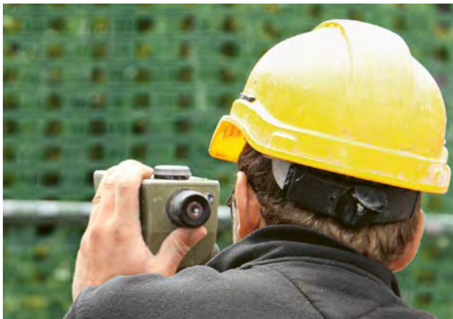
1. Déterminer le point le plus élevé de la dalle
