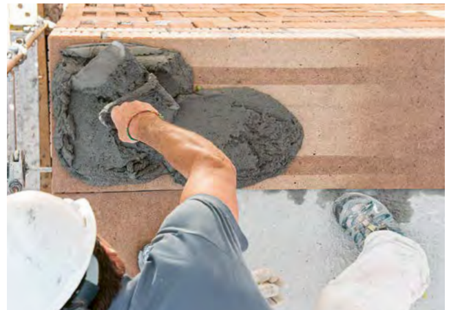
4. Appliquer le lit de pose
