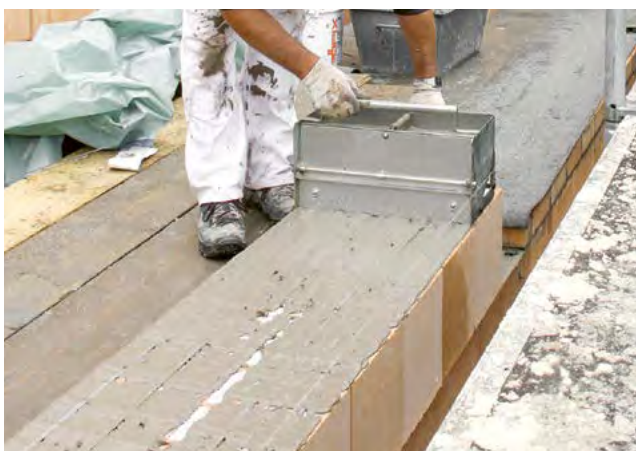
5. Avant de continuer le maçonnerie, couvrir une nouvelle fois avec du mortier
