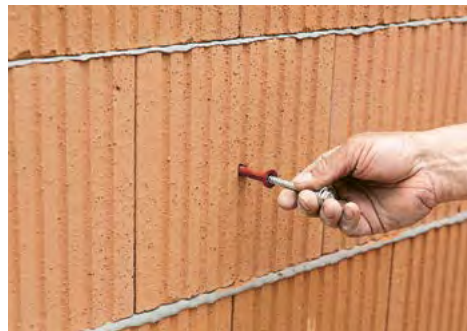
2. Placer la cheville (évent. avec une vis)
