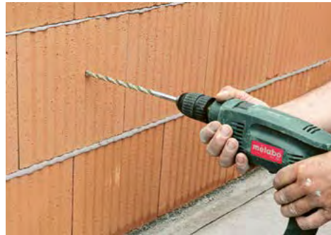
1. Percer sans percussion ou frappe avec un foret en carbure de tungstène affûté
