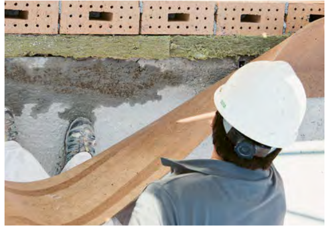
2. Dérouler la couche de séparation pour le nouveau mur d'étage, p.ex. l'appui de mur Porotherm Pronouvo
