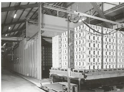
Nach etwa 47 Stunden verlassen die Wagen mit den fertig gebrannten Backsteinen den Ofen.
