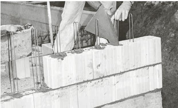
Anschliessend werden die Löcher mit Mörtel verfüllt.
