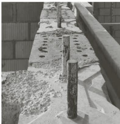
Das KeX<sup>®</sup> Schubelement, der KeX<sup>®</sup> Verband und der Calmo Backstein mit normalem Mauermörtel vermauert, bilden als System ein duktileres Mauerwerk, welches die Anforderungen der Normen SIA 261 und SIA 266 in Bezug auf die Erdbebenbelastung erfüllt.
