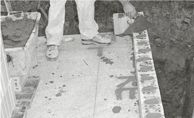
In der ersten Lage murfor® RE wird Mörtel verfüllt. Da der Entscheid für murfor® RE erst nach dem Betonieren der Decke fiel, ist das RE Mauerwerk mit eing Bohrten Bewehrungsseisen in die Betondecke verankert worden. Normalerweise wird die Einspannung in die Betondecke mit dem Anschlusskorb RE 53/15 A ausgeführt.
