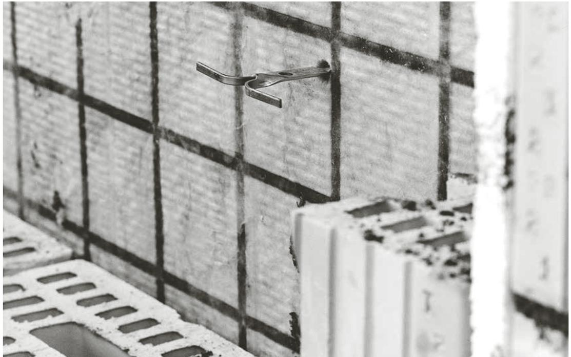
ZZ Spiralanker, welcher in der hinteren Schale mittels einer mit Zweikomponenten-Mörtelmasse gefüllten Siebhülse versetzt wurde.
