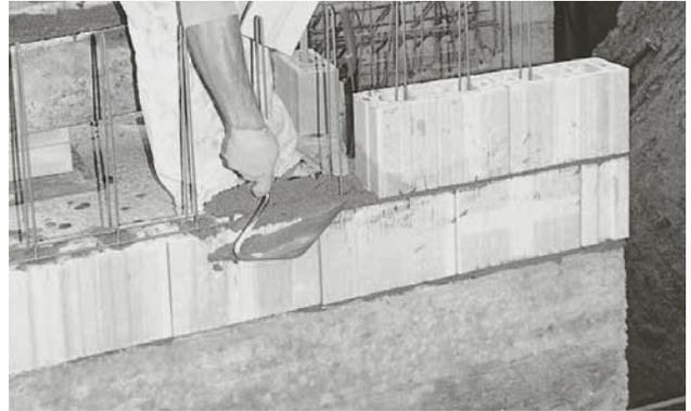
Nach dem Setzen des ersten Bewehrungskorbs RE 58/15 wird die zweite Lage aufgemauert.
