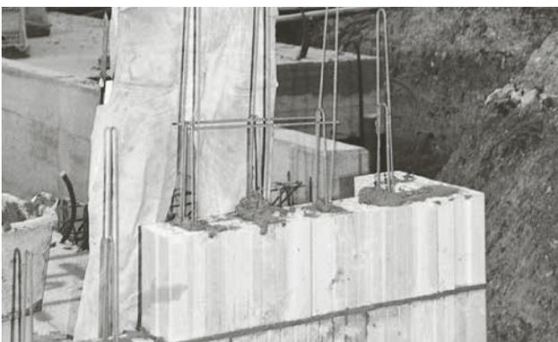
Nach weiterem Verfüllen der 3. Lage wird der Bewehrungskorb RE 58/15 versetzt. Durch das Versetzen der Körbe wird der Mörtel jeweils verdichtet.
