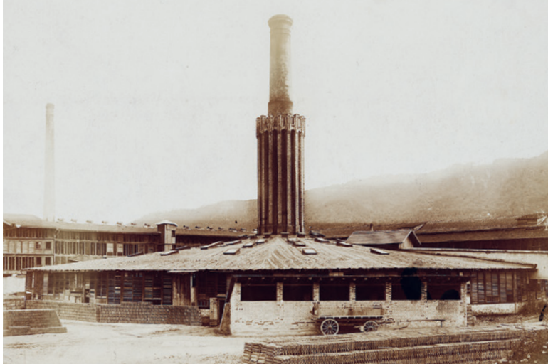
Der Ringofen der Mechanischen Backsteinfabrik in der Binz im Jahr 1915. (© Bau- geschichtliches Archiv der Stadt Zürich)
