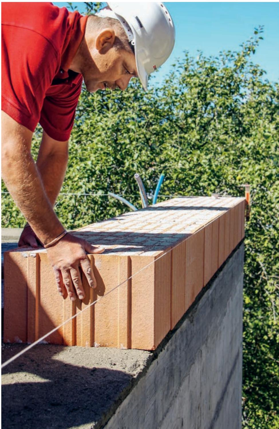
La maçonnerie à briques rectifiées exige un support absolument plan. Elle ne permet aucune correction lors du montage. Il s'agit donc de créer en premier lieu un lit de pose. Celui-ci égalise les irrégularités de la surface de la dalle et évite ainsi toute compensation de niveau ultérieure.
