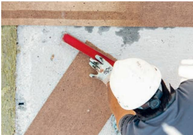
3. Couper l'appui de mur Porotherm Pronouvo
