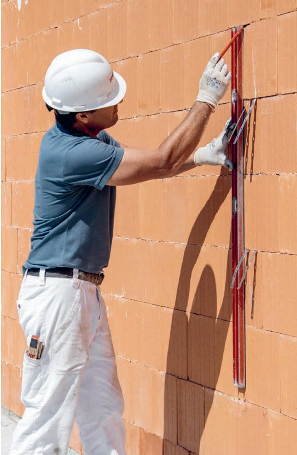
Les valeurs de résistance élevées de la maçonnerie à briques rectifiées réduisent au minimum le besoin d'armatures supplémentaires. Des mesures supplémentaires sont requises uniquement pour l'accrochage des murs intérieurs et dans les zones avec des concentrations de charges, p. ex. sur/sous des ouvertures. Il faut veiller à ce que les bandes d'ancrage soient bien noyées et que l'armature de joint d'assise soit couverte par un joint d'env. 2–3 mm.
