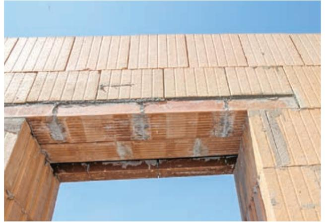
2. Remplir les joints verticaux de mortier en couche mince (trempé)
