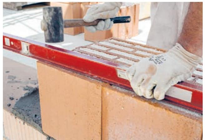
6. Commencer la première couche « mouillé sur mouillé » ou après séchage avec le mortier en couche mince
