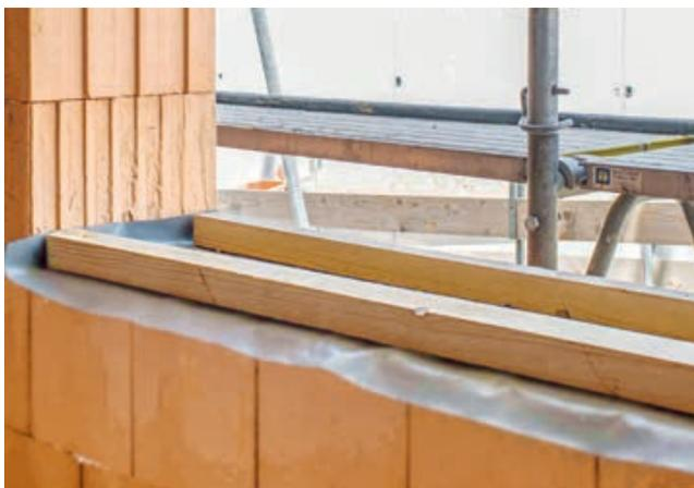
5. Protéger l'appui des intempéries pendant la phase de construction
