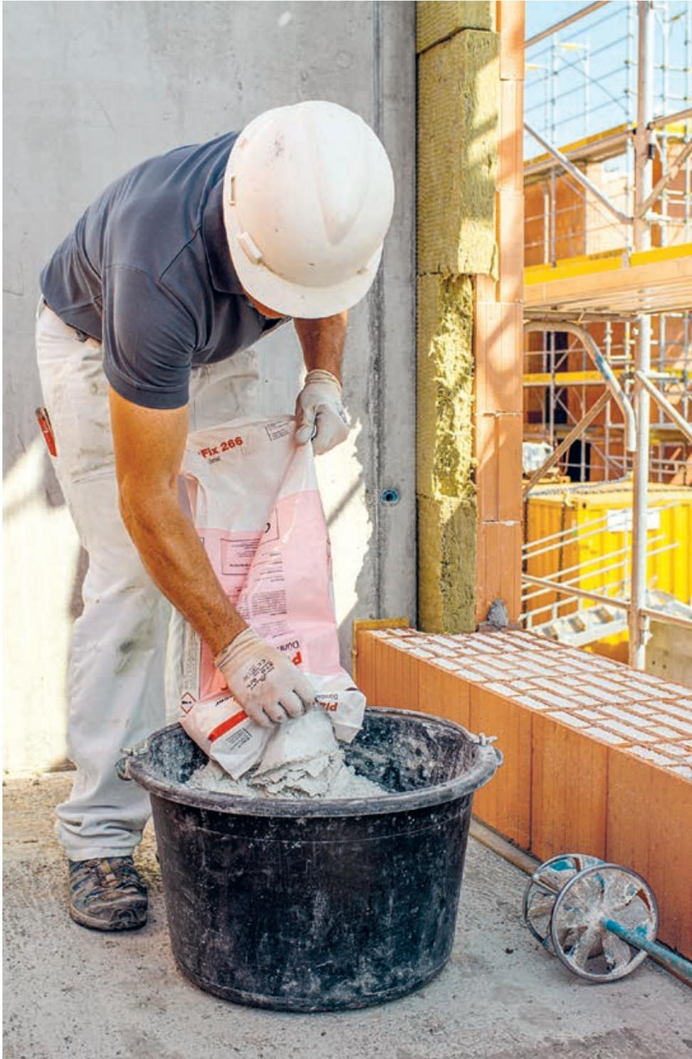
Le mur est monté d'un angle à l'autre avec une couche de 1mm de mortier en couche mince. Les briques sont endentées et serrées bout à bout. On atteint une efficacité maximale lorsqu'un collaborateur pose le mortier à l'aide de la luge et un autre les briques.
