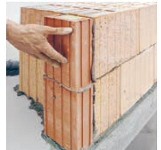
2. Simple et sûr : la coque de butée est collée ultérieurement sur le côté de l'embrasure avec du mortier en couche mince.
