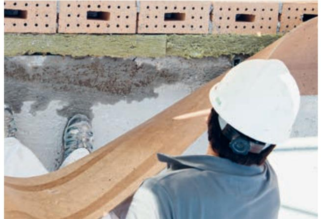
2. Dérouler la couche de séparation pour le nouveau mur d'étage, p.ex. l'appui de mur Porotherm Pronouvo
