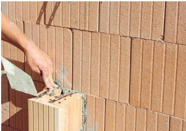
3. Monter le mur intérieur et le raccorder
