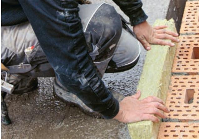
1. Maçonner le parement de manière conventionnelle après le bétonnage Isoler la tête de dalle avec un isolant souple
