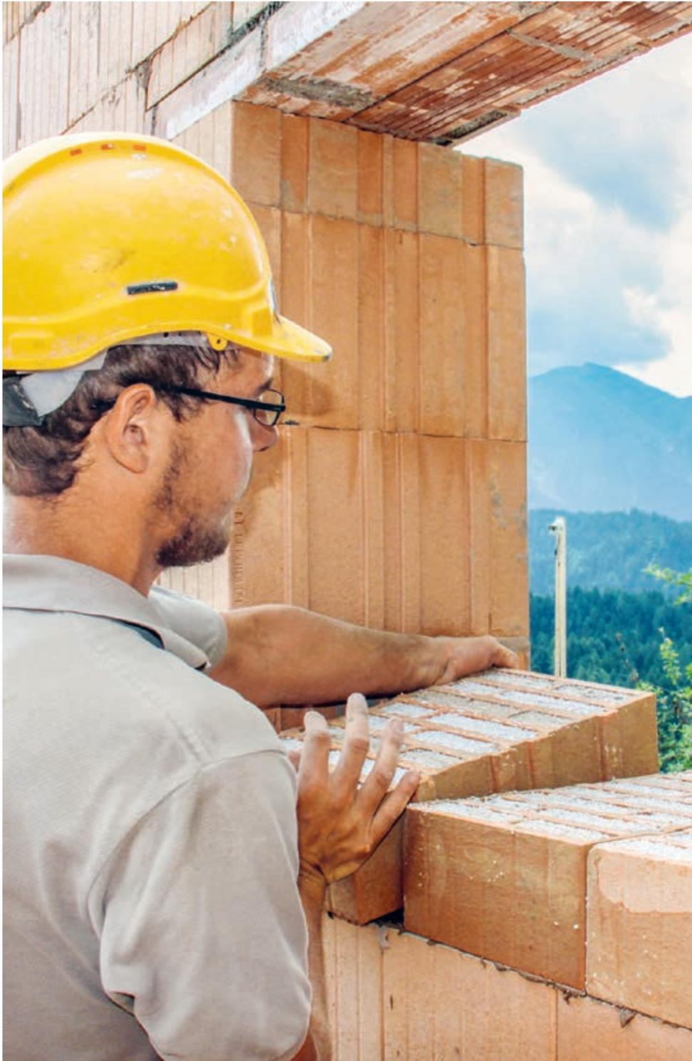
Pour former une ouverture, la paroi est laissée vide sur toute la largeur. Il y aura donc des briques coupées dans la zone du linteau. Celles-ci sont maçonnées à l'envers afin d'éviter que la perlite ne s'écoule et les alvéoles ouvertes sont ajustées à la brique voisine. Les embrasures sont exécutées avec des éléments en argile isolés.
