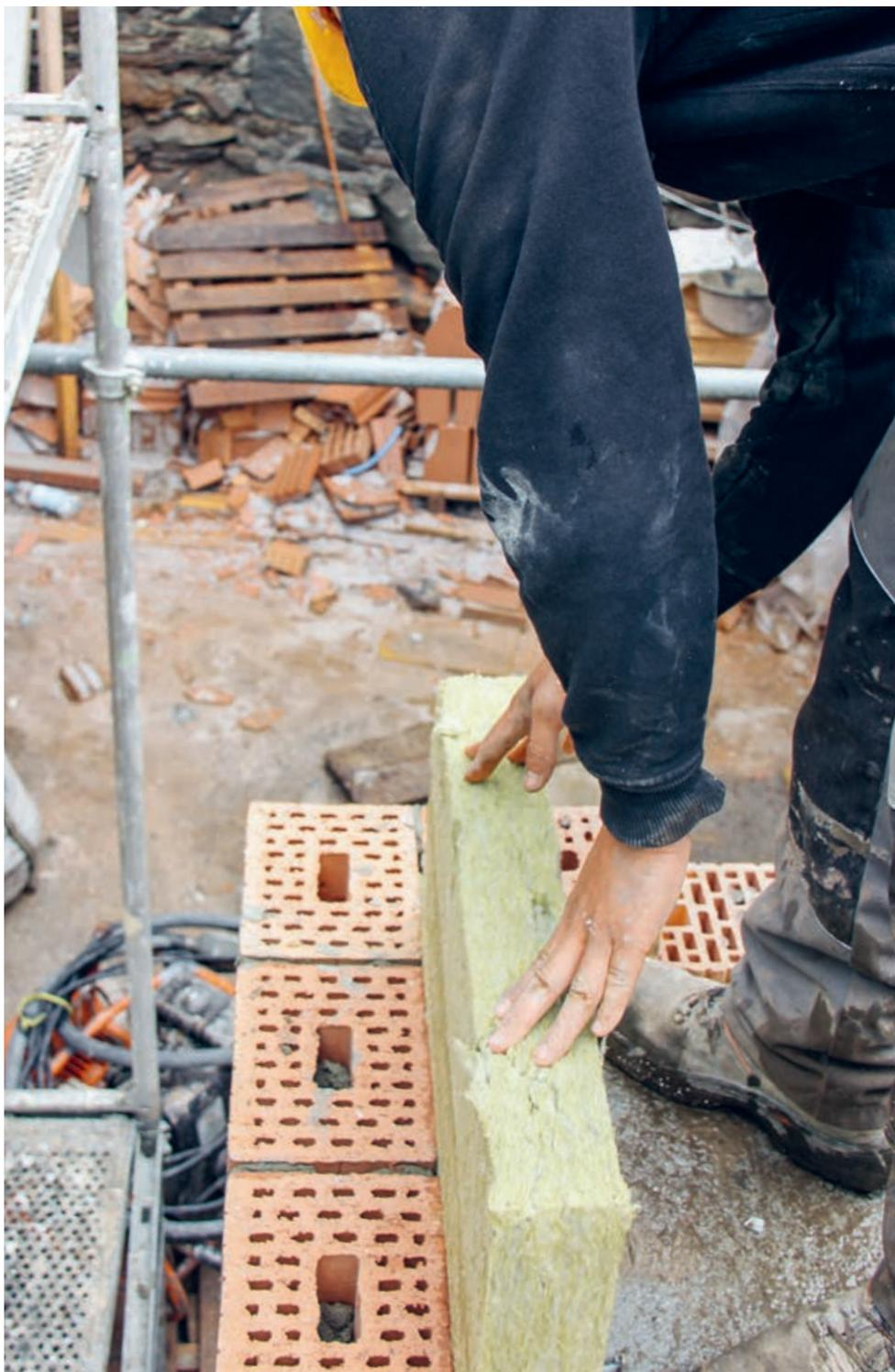
Après le coffrage de la dalle en béton, le parement de dalle est maçonné avec des briques PlanModul, Swiss Modul ou Calmo, selon la hauteur. L'isolation est insérée afin de permettre la torsion de la dalle en béton et de procéder à l'isolation de la tête de dalle.
