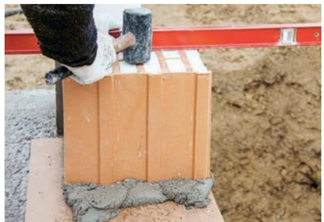
6. Aligner horizontalement et verticalement à l'aide d'un niveau à bulle et d'un marteau en caoutchouc
