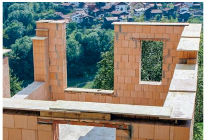
6. Protéger les surfaces horizontales, p.ex. le couronnement de mur pendant la phase de construction
