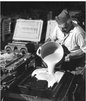
← Moulage dans un moule de plâtre, atelier de moulage Istighofen
